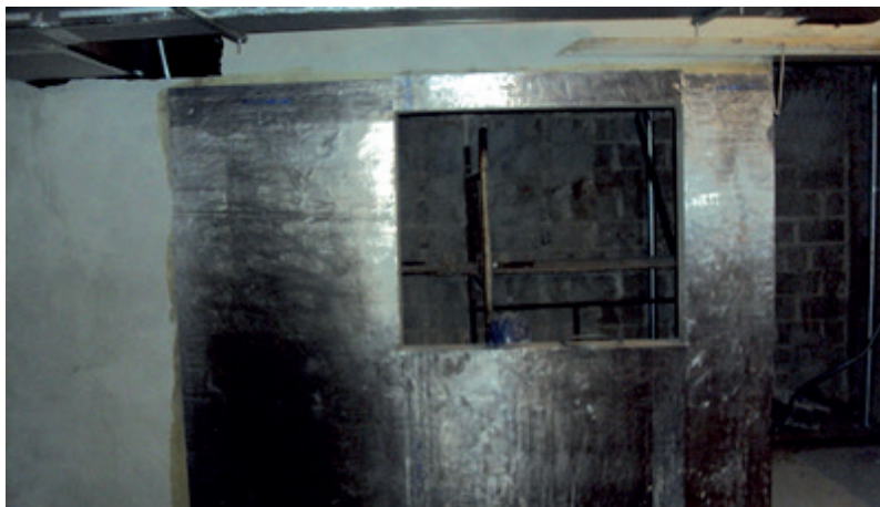
Figura 4.3 | Blindagem nas paredes em construção, com concreto e folhas de chumbo
