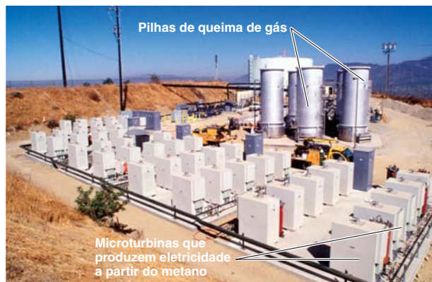
Figura 28.11 Produção de metano a partir de resíduos sólidos em aterros. O metano acumula-se nos aterros e pode ser usado para energia. Esta instalação próxima a Los Angeles tem 50 microturbinas que geram eletricidade a partir do metano produzido em um aterro. Logo atrás das microturbinas estão cinco pilhas de queima de gás que encobrem as chamas do excesso de metano queimado – uma exigência para que as aeronaves não confundam isso com a iluminação do aeroporto.
